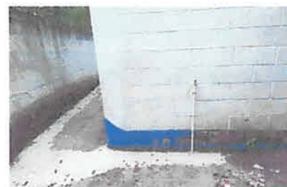
Foto 4: sustición de llave para chorro de agua.
