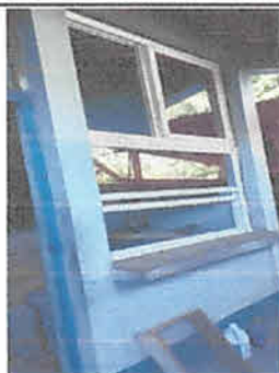
Foto1: Instalación de una ventana PVC
