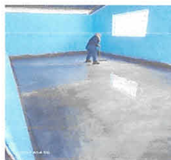
Foto 2: piso de concreto finalizado y pulido.
