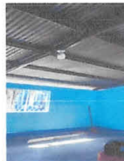
Foto 6: sustitución de bombillas.
