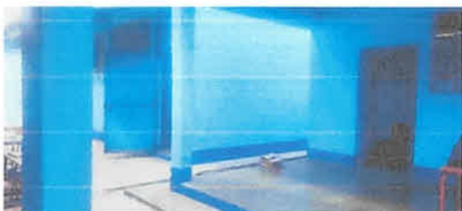
Foto 3: intados los ambientes escolares las 6 aulas, 1 cocina y dirección.
